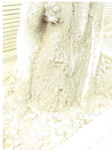
被害状況写真
